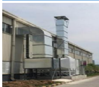
二套处理装置及排气筒
