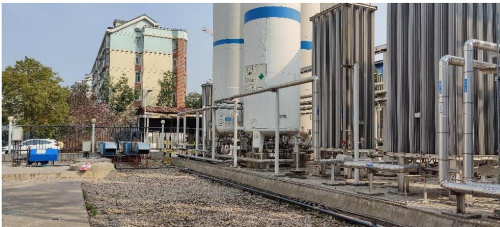
气化器喷淋水收集装置
