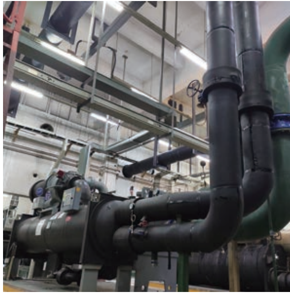
製冷站管道改造
