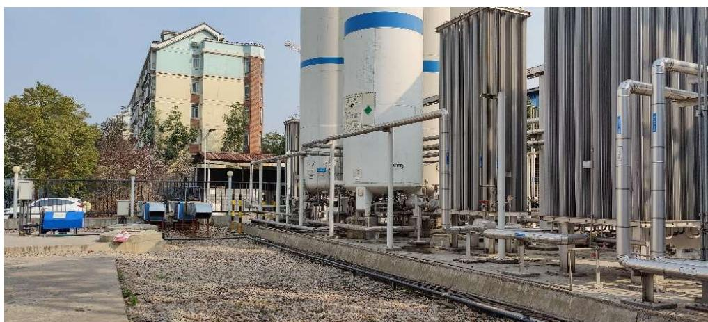
气化器喷淋水收集装置
